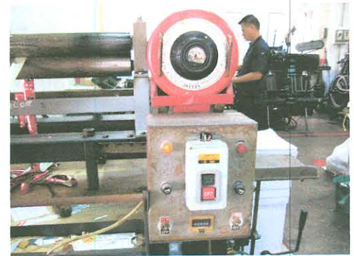
4. TRANSFORMER (ปรับค่ากระแสไฟฟ้าเข้าแผ่นความร้อน)
