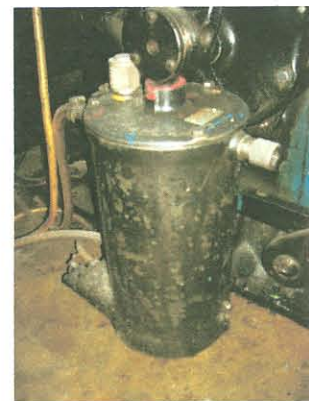
6. หม้อต้มใหญ่ (ควบคุมลมทั้งระบบ)
